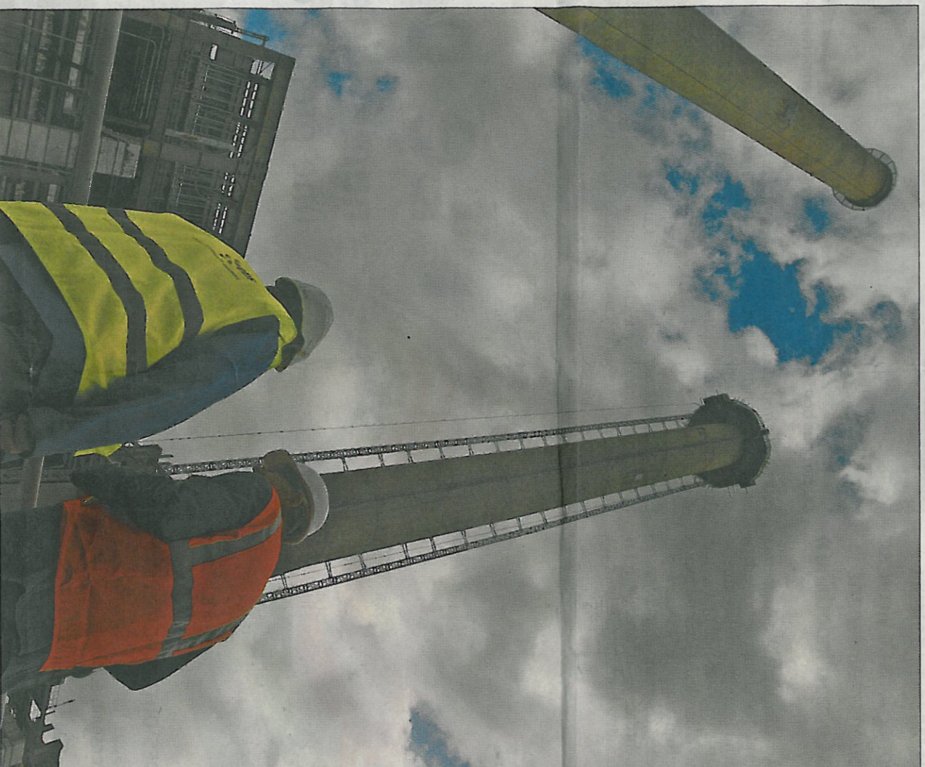
Début octobre, il ne restera plus que deux cheminées de forme originale. PHOTO THIERRY DAVID
